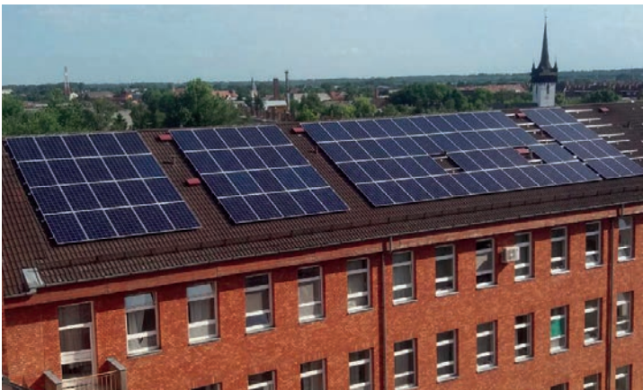
→ SOLLIGHT, KRANKENHAUS FEHÉRGYARMAT, 420 KWP
