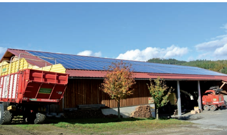
→ HELLIOS, ÖBERÖSTERREICH, 150 PV-ANLAGEN MIT INSGESAMT 3,5 MWP
