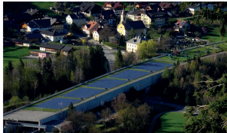
→ ENUMTECH, EINHAUSUNG TREBESING, 300 KWP
