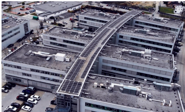
→ TECHNOLOGIEZENTRUM, EISENSTADT, 123 KWP
