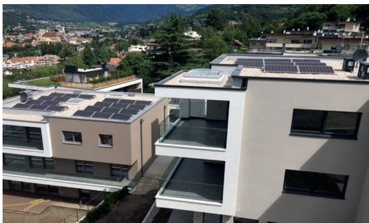
→ BRESSANONE, BOZEN, ITALIEN, 100 KWP
