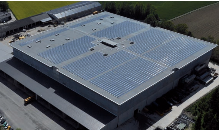
→ ENERGIE AG, WOLFERN, 800 KWP
