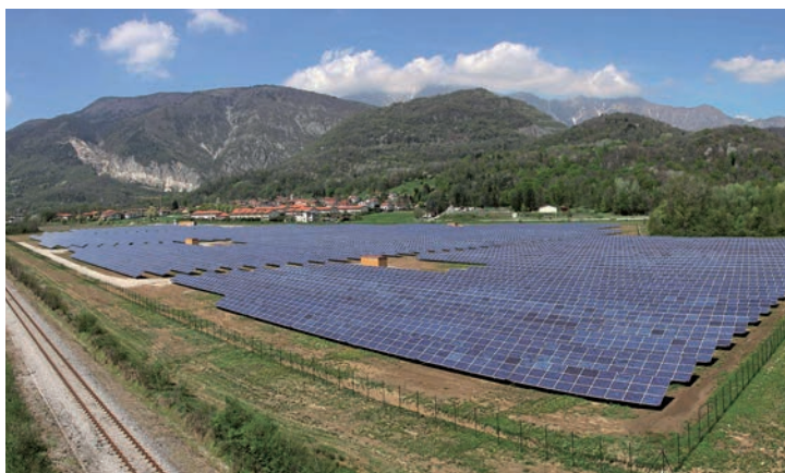
→ SOLARPARK MANIAGO, ITALIEN, 5 MWP
